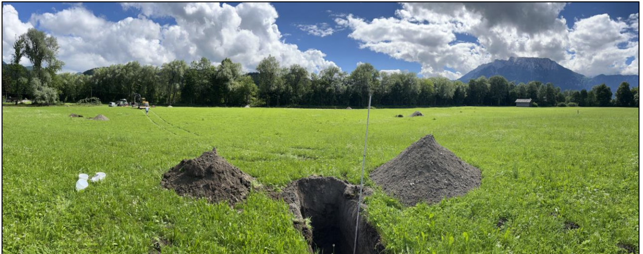
Abbildung 1 – Baufeld Blick nach Südosten
